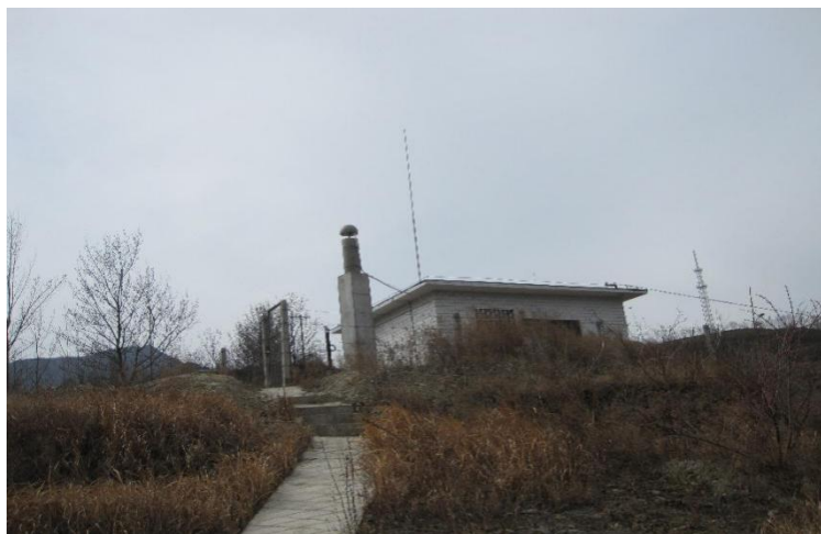
图 5.3.3 略阳（新）GNSS 观测站外观现状图
