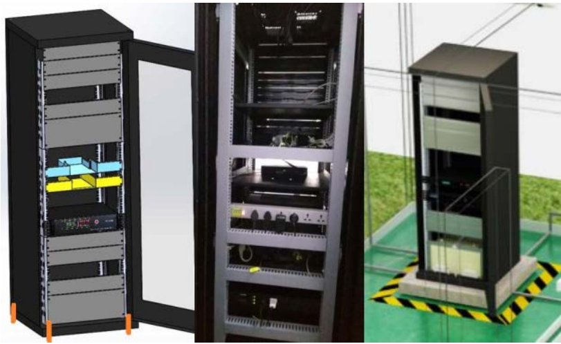
图 5.1.17 机柜固定及配置效果图
