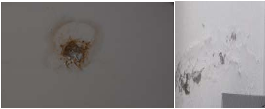
图 5.1.6 镇巴地震观测站室内墙壁现状图
