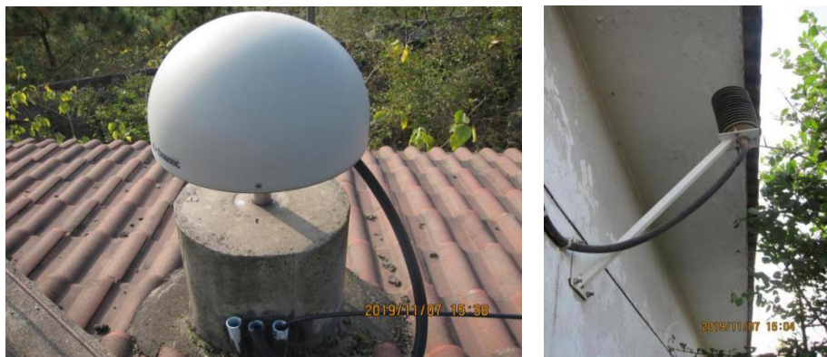
图 5.2.5 勉县 GNSS 观测站传感器布设
