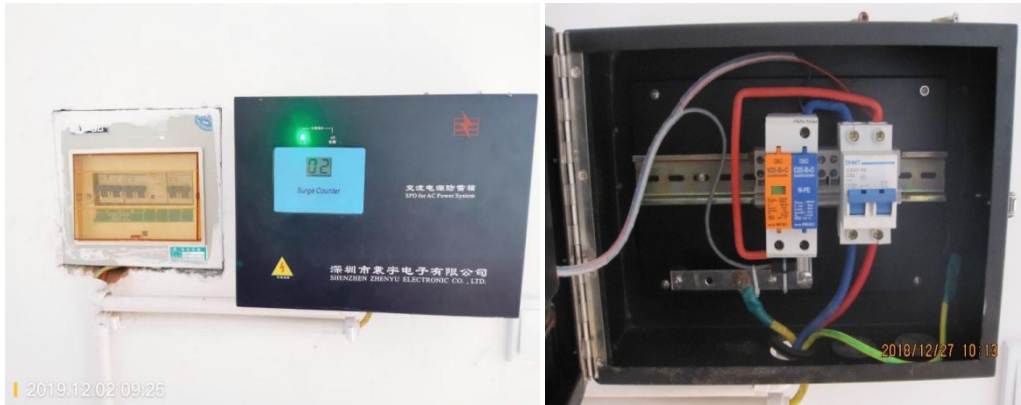
图 5.3.9 室内防雷箱和配电箱现状图
