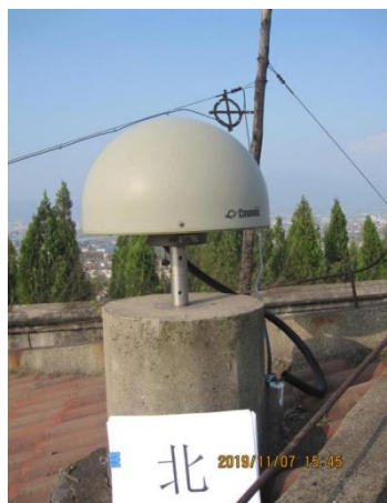
图 5.2.6 勉县 GNSS 观测站电线杆及通讯线杆现状
