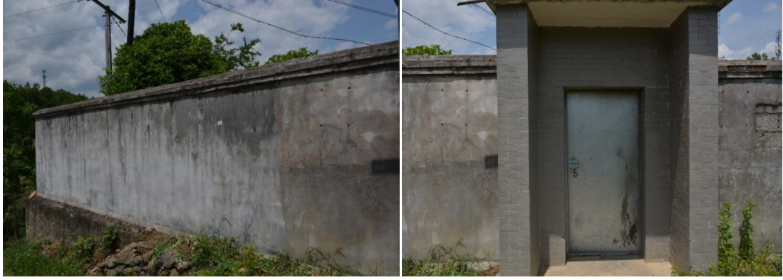
图 5.1.5 镇巴地震观测站围墙大门现状图
