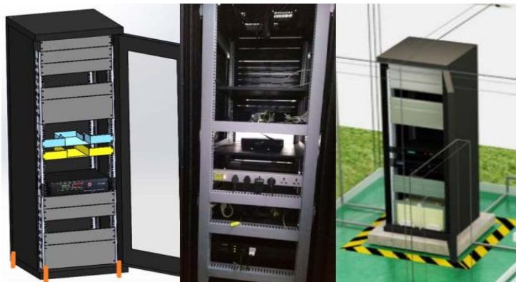
图 5.2.9 机柜固定及配置效果图
